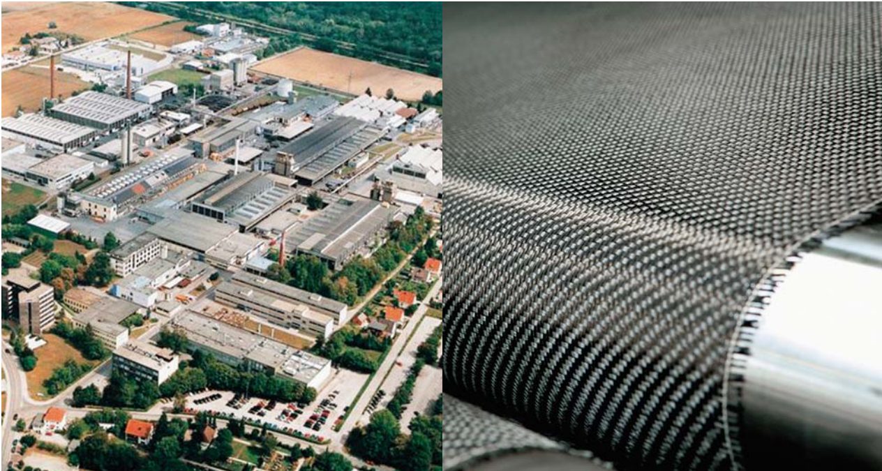
Foto: SGL CARBON GmbH, Standort Meitingen
