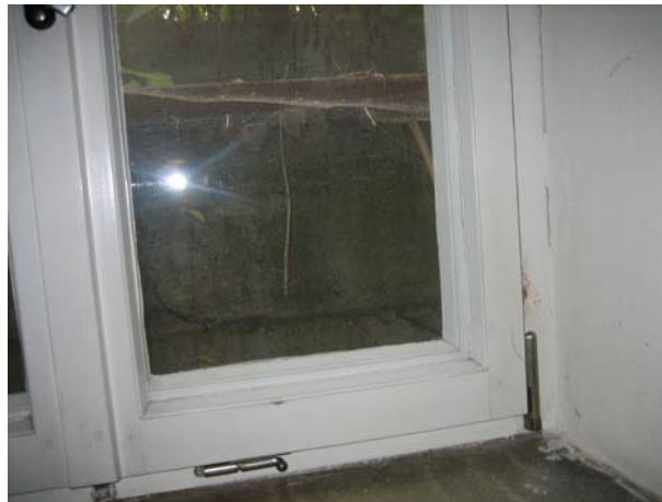
Abbildung 4-13: Kastenfenster im Untergeschoss des Küchentrakts ostseitig
