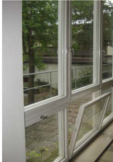
Abbildung 4-12: Kastenfenster im Gang zum Speisesaal
