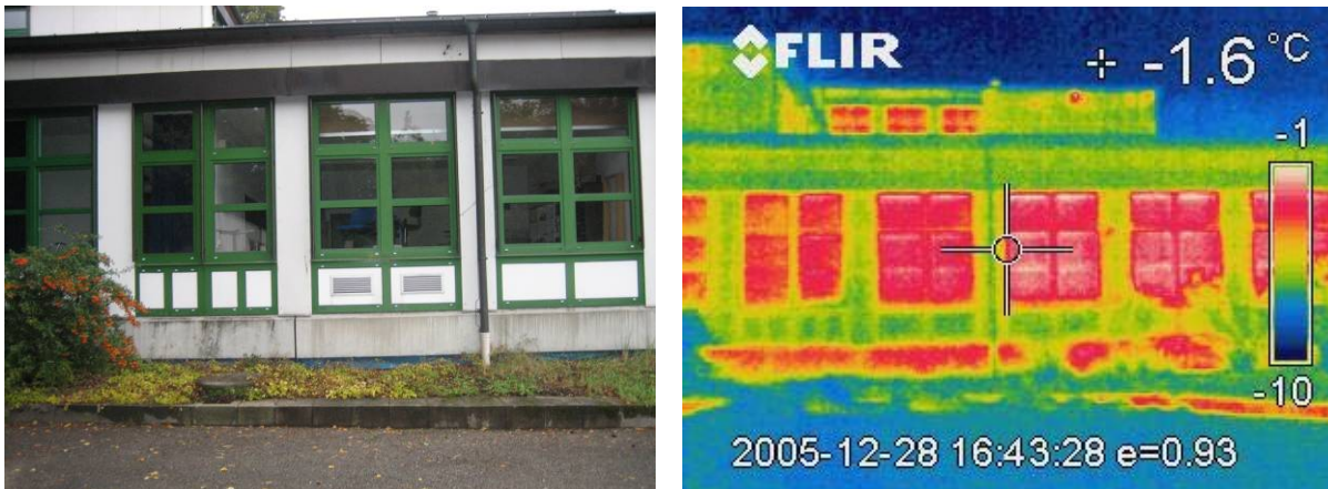
Abbildung 4-18: Westfassade des Kollegstufentraktes mit außenliegenden Betonelementen
