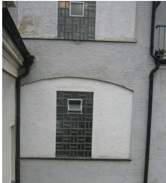
Abbildung 4-9: Neubau Ostseite: Glasbaufenster
