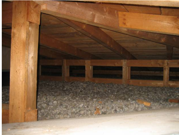
Abbildung 4-19: Dach über dem Kollegstufentrakt
