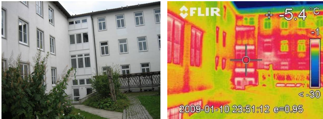
Abbildung 4-14: Nordfassade Gymnasium, Treppenhaus
