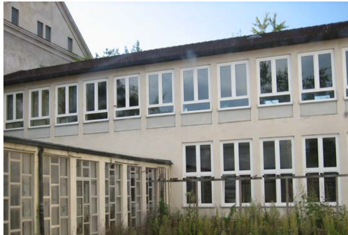
Abbildung 4-11: Neue Fenster an der Südseite der Vorhalle
