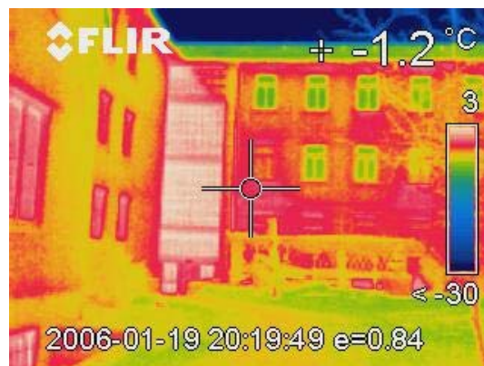
Abbildung 4-15: Nordfassade Gymnasium, altes Treppenhaus(mit Glasbausteinen)
