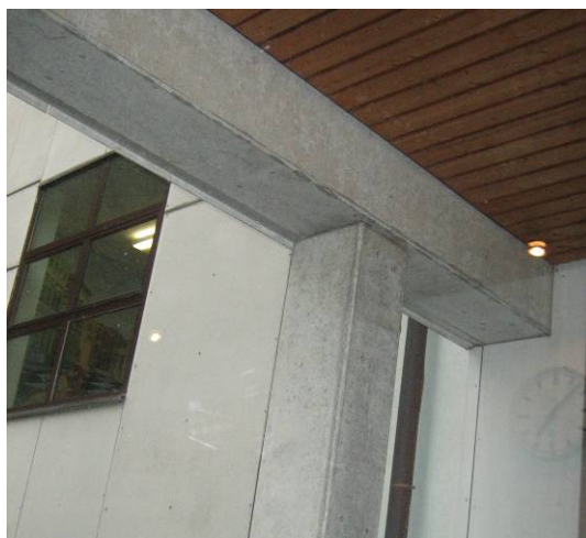
Abbildung 4-20: Pausenhalle mit außen liegender durchgehender Betonsäule
