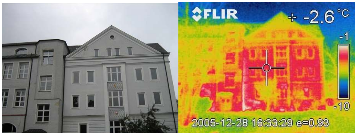
Abbildung 4-5: Foto (links) und Thermografie-Aufnahme (rechts) der Westfassade
